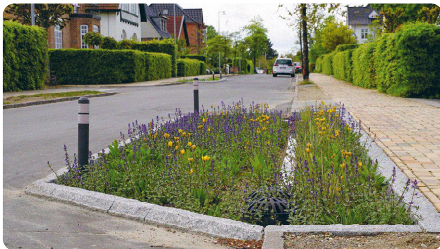
Foto 39. Liiklust aeglustav vihmapeenar sõiduteel Taanis. Allikas: www.vandcenter.dk
