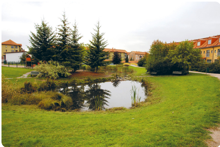
Foto 2. Sademevee käitlusahel Soomes Vantaa linnas. Elamualadel tekkiv sademevesi juhitakse vett läbilaskvate katendite kaudu viibetiiki ja sealt omakorda oja. Foto: Sandra Oisalu
