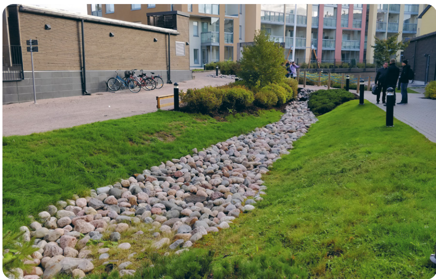
Foto 35. Voolukiirust aeglustavate takistustega (kivid) immutus- ja äravoolunõva Soomes Vantaas. Foto: Gen Mandre
