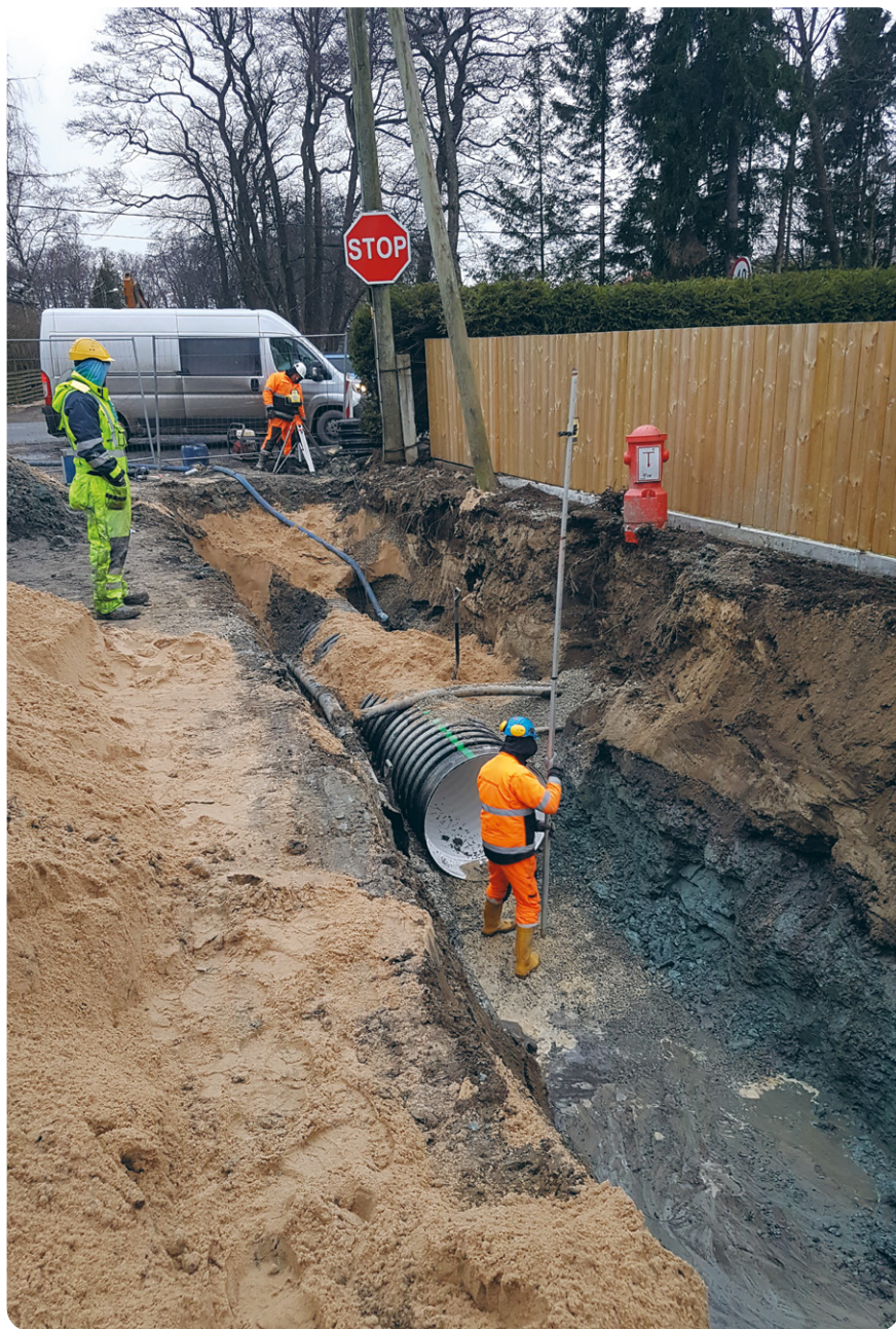
Foto 54. Sademeveekollektori ehitus Viimsi vallas Haabneeme alevikus. Foto: Taavi Valgmäe
