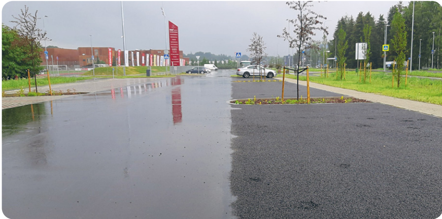
Foto 23. Dreenasfalt (paremal) ja harilik vett mitteläbilaskev asfalt (vasakul) vihmajärgel Viimsi vallas Haabneemel. Foto: Taavi Valgmäe
