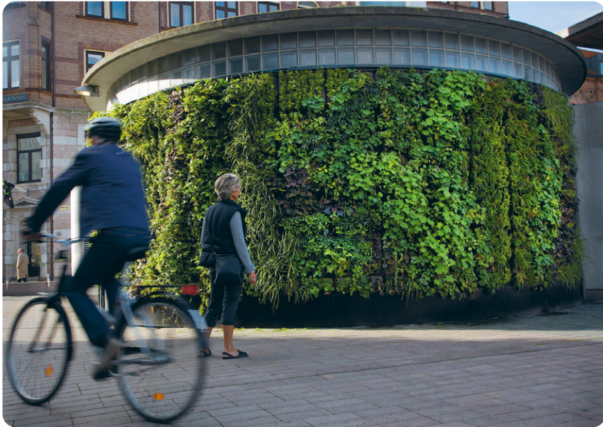
Foto 13. Roheseinaga kaetud pumphahoone Roots in Helsingborgis. Foto: Eva Lie
