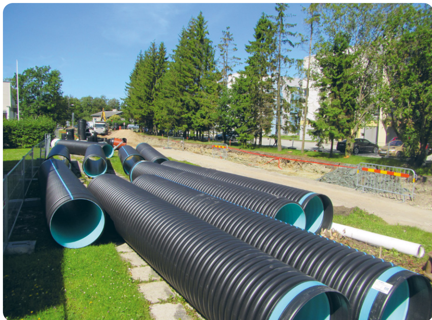
Foto 55. Sademeveetorustiku rajamistööd Viimsi vallas Haabneemes. Foto: Taavi Valgmäe
