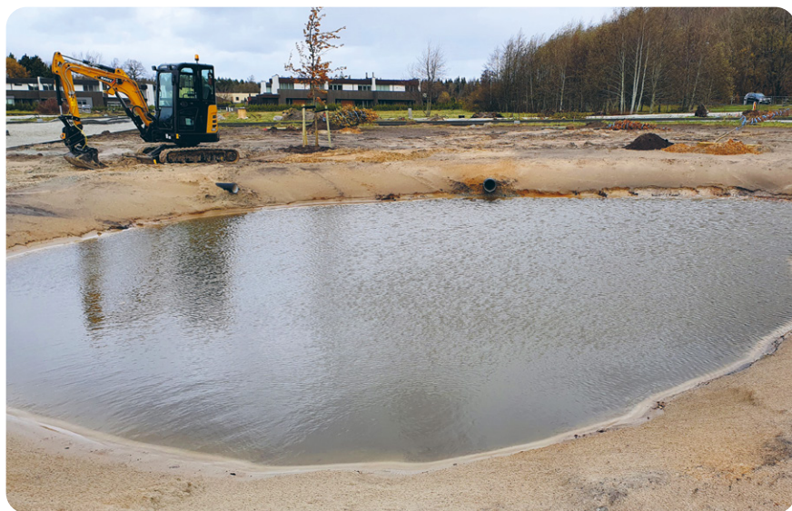
Foto 49. Tiigi rajamine Viimsis Põldheina tee parklas. Liivased tiigikaldad taimestati erosiooni vältimiseks looduslikul moel, erosioonitõkkematte kasutamata. Tiigi põhja moodustab savine kiht. Foto: Imre Saar
