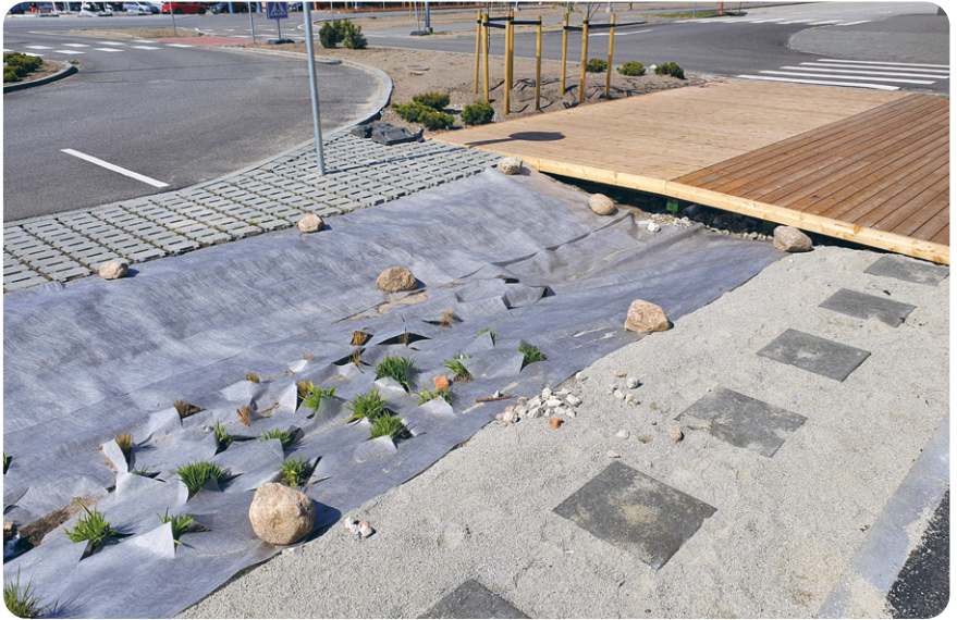
Foto 41. Vihmapeenra rajamine Viimsis Haabnemee kooli parklas. Vihmapeenar asub kahe erineva filterriba vahel ja piirneb otsast jalakäijate platvormiga. Foto: Alar Mik
