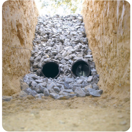
Foto 32. Imbkraavi rajamine. Allikas: Wikimedia Commons ( www.commons.wikimedia.org/wiki/File:FrenchDrain-02.jpg )
