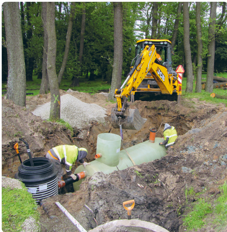
Foto 53. Liiva-mudapüüduuri paigaldamine Viimsi vallas Haabneemes. Foto: Taavi Valgmäe
