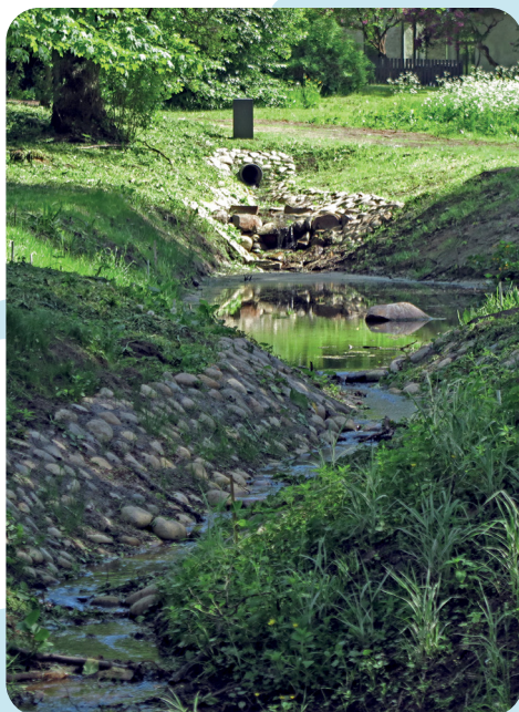
Korrastatud sademeveekraav Viimsi mõisa pargis. Foto: Merle Kuris
