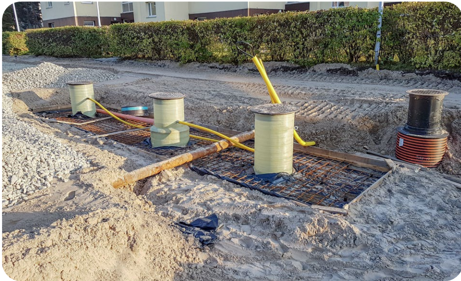
Õli- ja liivapüüdu paigaldus. Haabneeme, Viimsi. Foto Alar Mik.
