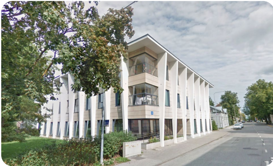
Sademevee kogumis- ja kasutamissüsteem Tartus, Vanemuise 45. Sambad varjavad vihmaveetorusid, mida mööda katusest kogutud sademevesi voolab maja alla peidetud 13 kuupmeetri suurusesse kogumispaki. Kogutud sademevett kasutatakse maja WC-pottides ja pesumasinate. Foto: Google Maps street view.
