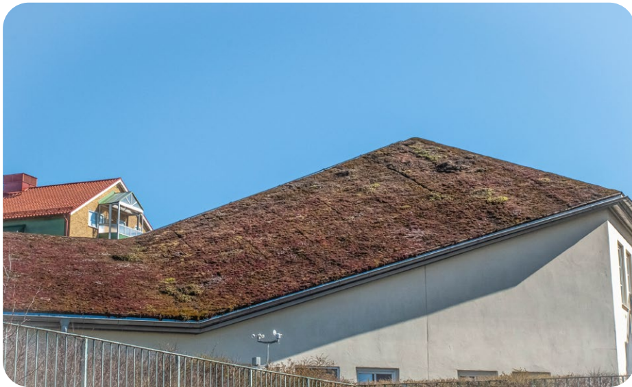
Ekstensiivset rohekatust saab rajada ka kaldpinnale. Malmö, Rootsi. Foto: Jolanda Lipu.
