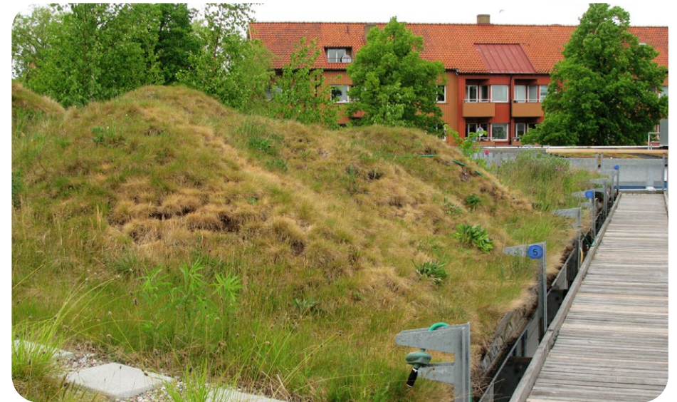
Intensiivne rohekatus (raske katus). Malmö, Rootsi. Foto: Gen Mandre.
