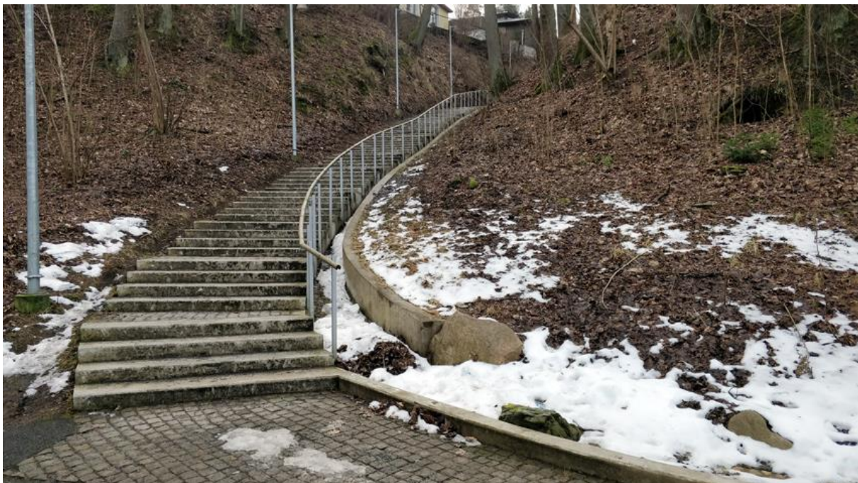
Foto 5. Vaade treppile ja selle küljel paiknevale sademevee rennile Trepil tänavalt.
